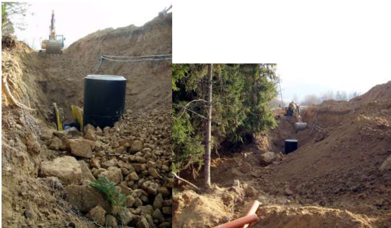
Fot. 2, 3, Przykład budowy kolektora zbiorczego w terenie górzystym.
