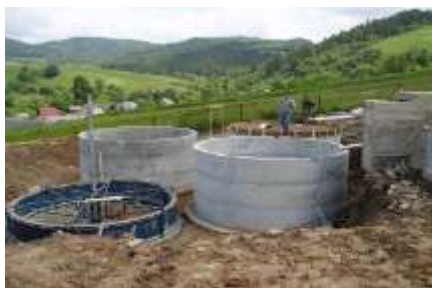
Fot. 82. Zbiorniki na gnojówkę (o objętości do 25 m 3 ) budowane systemem gospodarczym z wykorzystaniem tzw. form ślizgowych opracowanych w Instytucie
