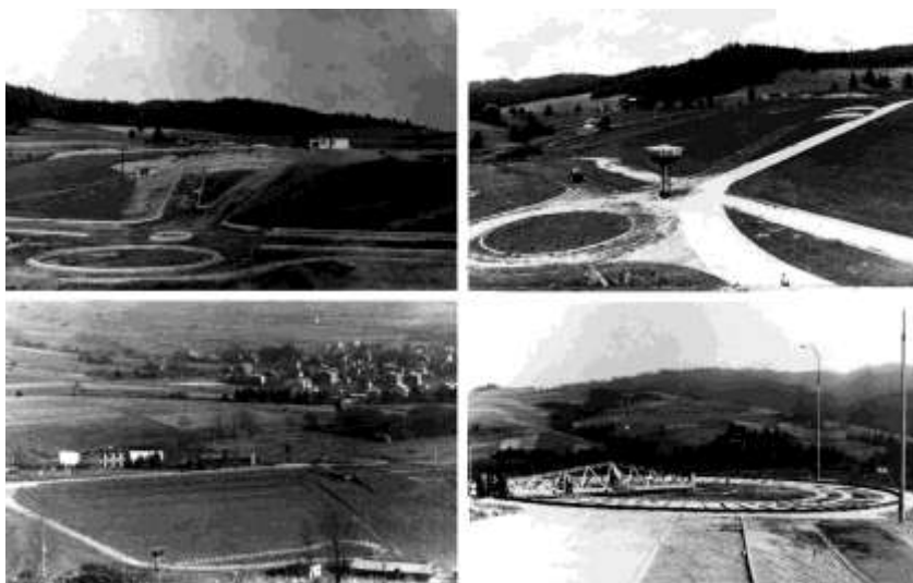
Fot. 10, 11, 12, 13. Część wyposażenia infrastruktury badawczej, kolejno: poligonowy tor badań z centrum zdalnego sterowania badanymi pojazdami, na dole z lewej lokalizacja stanowiska do badań agregatów pompowych i zraszaczy do deszczowni, z prawej kołowy tor przeszkód do badań niezawodności konstrukcji zestawów ciągnikowo-maszynowych i do badań trwałości opon rolniczych.
