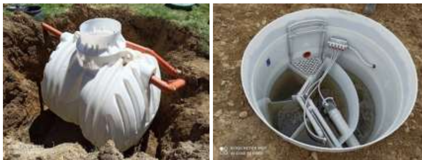
Fot. 102, 103. Przykład kontenerowych przydomowych oczyszczalni ścieków (POŚ), pracujących w systemie osadu czynnego, badanych obecnie w poligonowym kompleksie stanowisk w ITP PIB - GCB w Tyliczu
