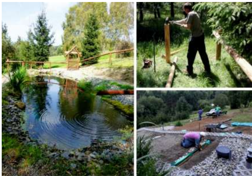
Fot. 92, 93, 94. Staw do odbioru i naturalizacji oczyszczonych ścieków, obok Grzegorz Skalniak- twórca drewnianej architektury w otoczeniu poszczególnych obiektów i Andrzej Jucherski przy pracach wykończeniowych stokowego złoża grunto-roślinnego
