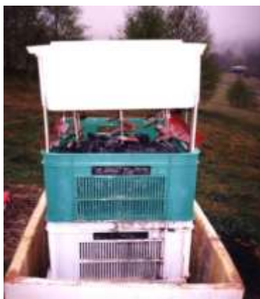
Fot. 67, 68, 69. Mikro oczyszczalnia BOKOMAF ze złożem ociekowym w ażurowych skrzynkach i osadnikiem wtórnym z recyrkulacją osadów
