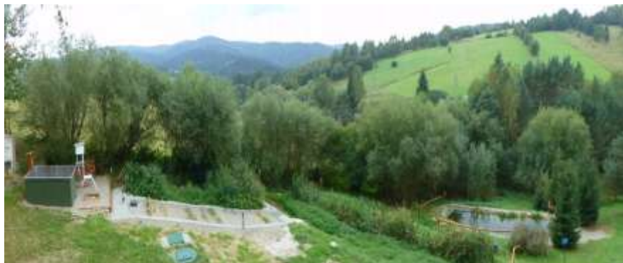
Fot. 99. Kompleks badawczy procesów oczyszczania ścieków na drodze filtracji w ośrodkach mineralnych, gruntowo-glebowo-roślinno-wodnych
