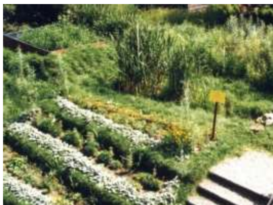
Fot. 73. Wieloczęłowa instalacja gruntowo - roślinna do oczyszczania ścieków domowych w gospodarstwie Krzysztofa Hamernika w Myszynie w gminie Krynica-Zdrój. Autorski obiekt doświadczalny
