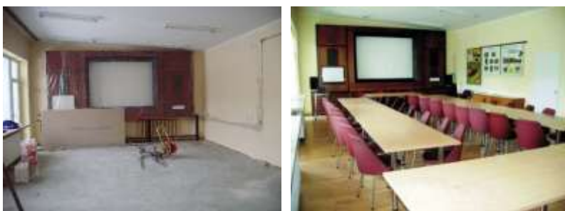
Fot. 89 Efekt modernizacji sali wykładowej wykonanej własnymi siłami
