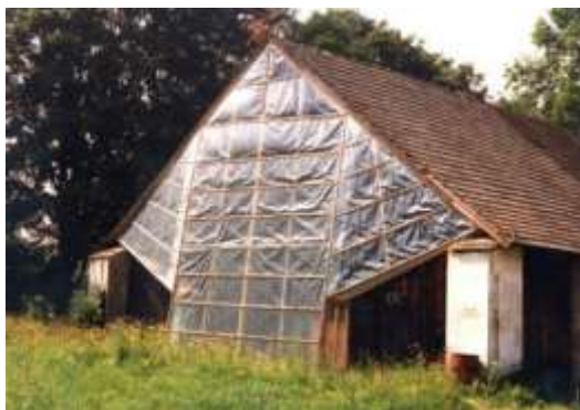
Fot. 84. Suszarnia do siana wykonana systemem gospodarczym z przyściennym kolektorem słonecznym
