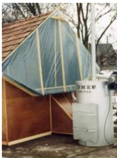
Fot. 85, 86. Nowa wersja konstrukcji pieca z wkładem trocinowym, obok suszarnia na owoce i warzywa z przyściennym kolektorem słonecznym wspomagana wymuszonym obiegiem powietrza ogrzanego w piecu z wkładem trocinowym
