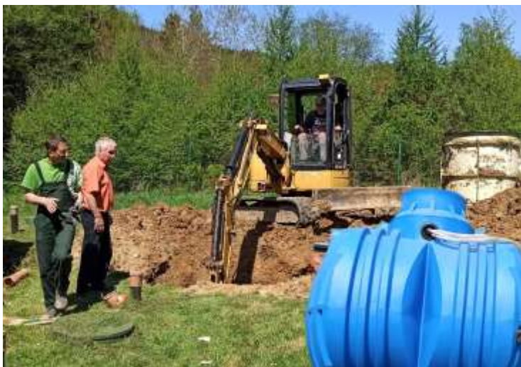
Fot. 104. Andrzej Walczowski i Grzegorz Skalniak przy montażu indywidualnej oczyszczalni ścieków na poligonie badawczym w GCB w Tyliczu (2022 r.)
