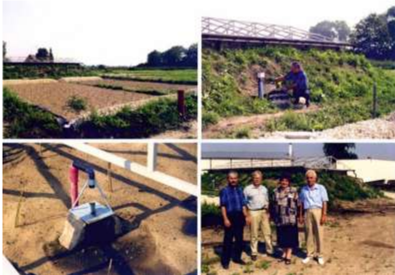
Fot. 77, 78, 79, 80. Wdrażana oczyszczalnia ścieków gruntowo roślinna z kombinacją złóż filtracyjnych zraszanych (przepływ pionowy ścieków) i o poziomym przepływie ścieków. Na jednym ze zdjęć: Andrzej Jucherski i Andrzej Walczowski w towarzystwie inwestorów
