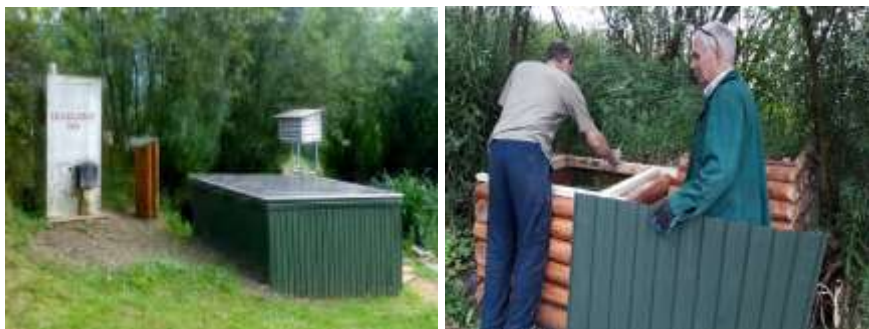
Fot. 90, 91. Grzegorz Skalniak i Andrzej Walczowski przy budowie obiektów technologicznych ścieżki
