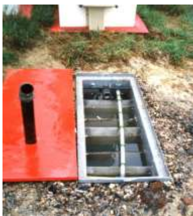
Fot. 67, 68, 69. Mikro oczyszczalnia BOKOMAF ze złożem ociekowym w ażurowych skrzynkach i osadnikiem wtórnym z recyrkulacją osadów
